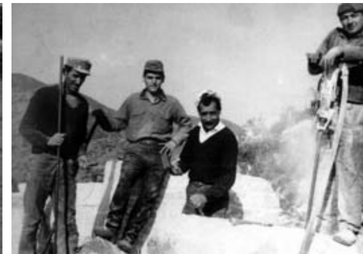
◉ All'estrema destra Ananias Korossoglou, papà di Giorgio, assieme ad alcuni operai nella cava di marmo dove lavorava
